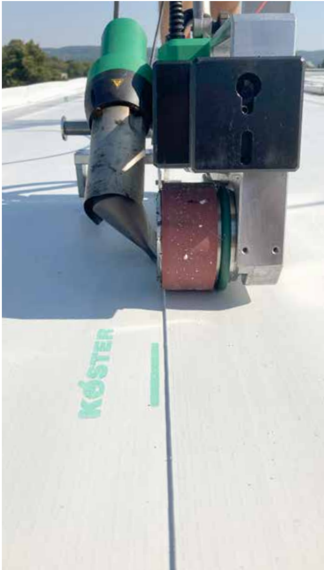
Verarbeitung durch Heißluftverschweißung
