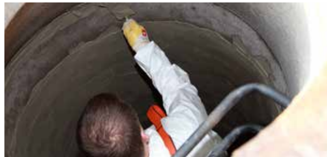
Anschluss des Abwasserschachtes an den Einstiegsbereich
