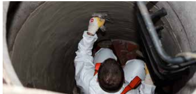
Aufziehen des Mörtels mit einer Kelle auf den feuchten Untergrund
