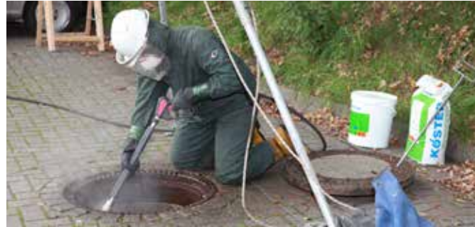
Untergrundvorbereitung (hier Hochdruckwasserstrahlen)
