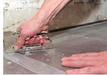
3 Aufbringen von KÖSTER Armierungsgewebe auf den Holzuntergrund
