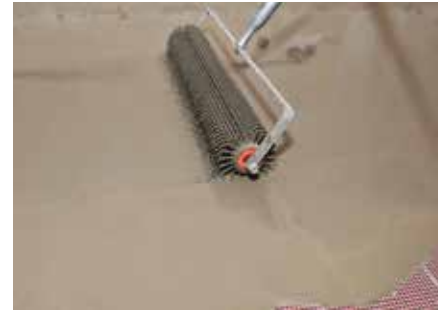
6 Abschließend das Material mit einer Stachelwalze entlüften
